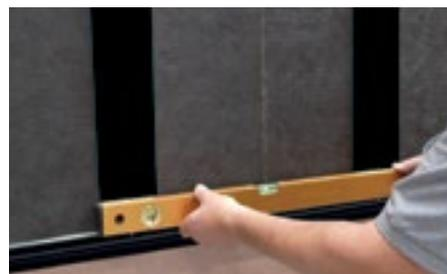
vous installerez le premier rail aluminium Modulo bas (long 3000mm). Celui-ci doit être parfaitement réglé horizontalement et coplanaire. Ce rail doit se monter avec 2 vis de fixation par appui (avec des trous fixes et des trous de glissement (perçement du rail diamètre 8mm pour une vis diamètre 4.8 mm)). Toutes les autres rangées seront montées à l'aide des rails aluminium Modulo.
