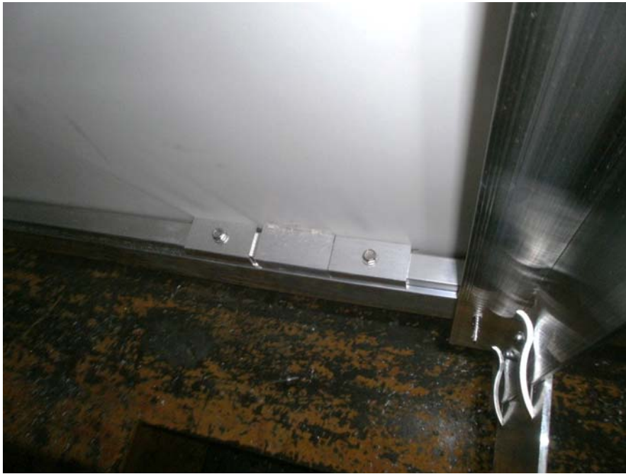
Figure A4 - Photo du principe des butées en bas des panneaux de largeur > 1500 mm (cf. § A3.6)
