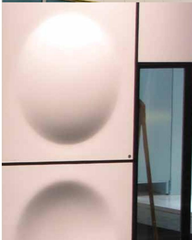
**Choisir le bon endroit |** Corian® permet un système intelligent de murs rideaux, comme le montre ce concept de Skandinaviska Glassystem, en utilisant une alternance d'empreintes concaves et convexes qui tirent profit de la malléabilité et de la fixation facile du matériau.
