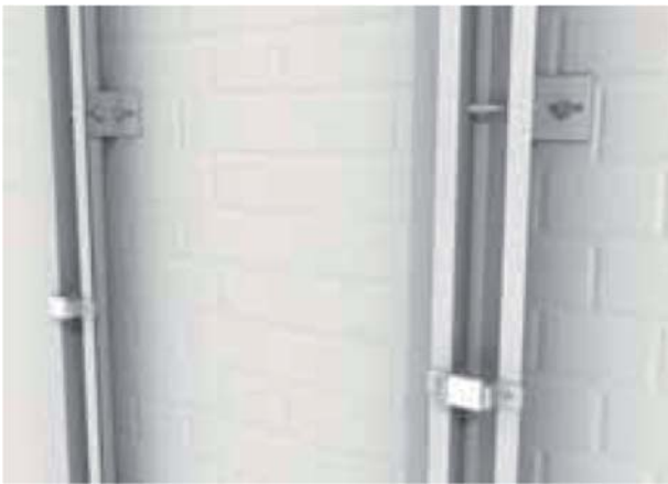
3. Fixation des pattes-agrafe
