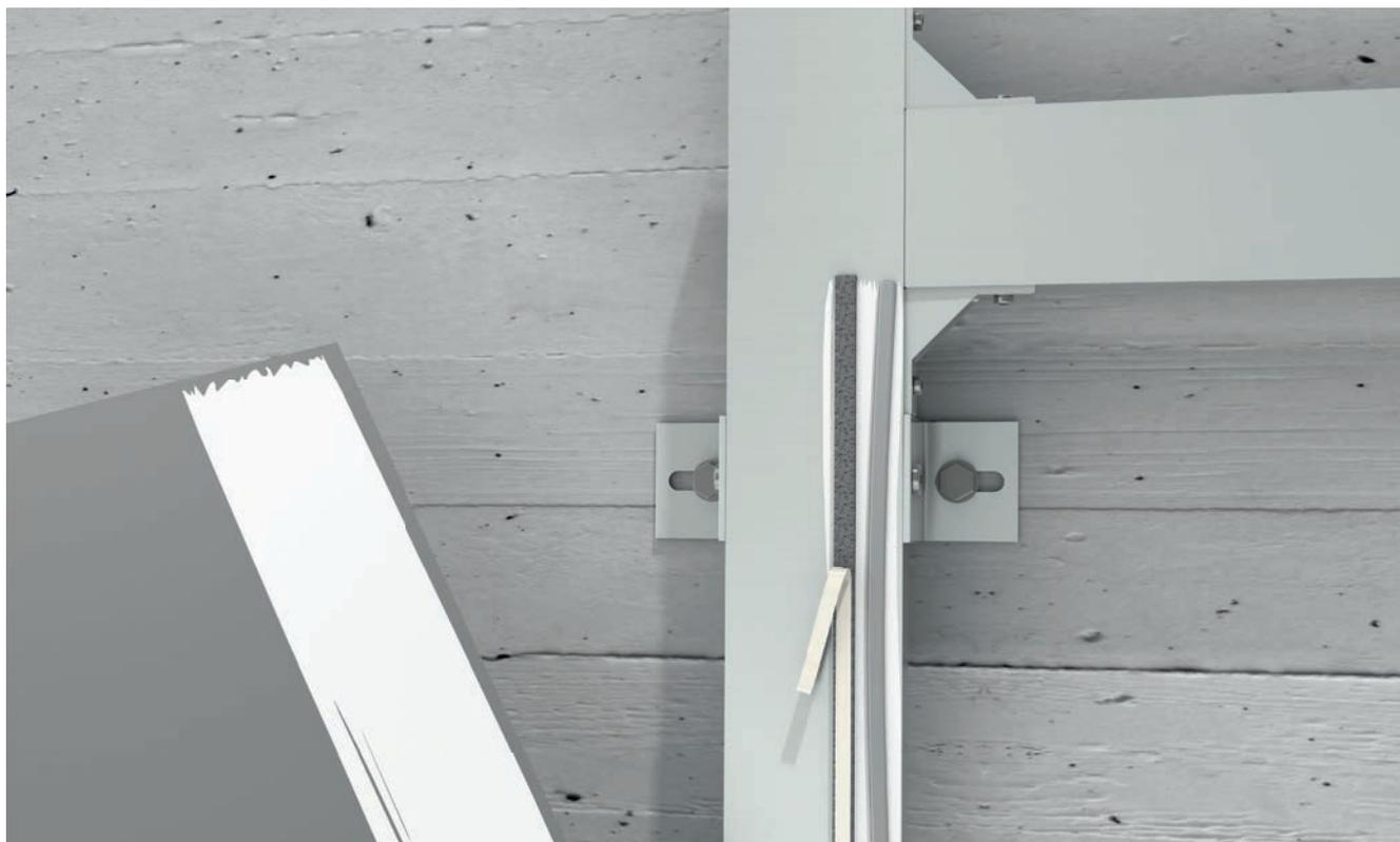
**1. Nettoyage de l'ossature secondaire.** L'ossature secondaire doit être propre, sèche, homogène, débarrassée d'huiles, de graisses, de poussière et de particules libres ou mal adhérentes. Il faudra éliminer les peintures, les coulis et autres revêtements.
