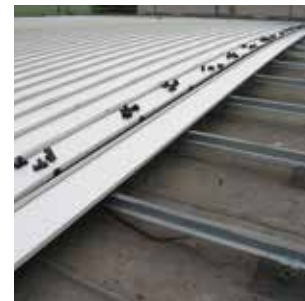
Fissaggio del manto di copertura Roofing fixing
