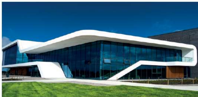
CI-DESSUS : La façade du Menai Science Park à Gierwen, au Pays de Galles, fabriquée en Corian® Solid Surface, dans le coloris Glacier White. Projet de FaulknerBrown Architects. Photo publiée avec la permission de CD (UK) Ltd., tous droits réservés. À DROITE : La façade de la communauté de communes de Lacq Orthes, en France, fabriquée en Corian® Solid Surface, dans le coloris Glacier White. Projet de Gille Bouches. Photo d'Arthur Péquin, tous droits réservés.
