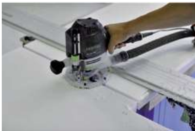
Défonçage en miroir
