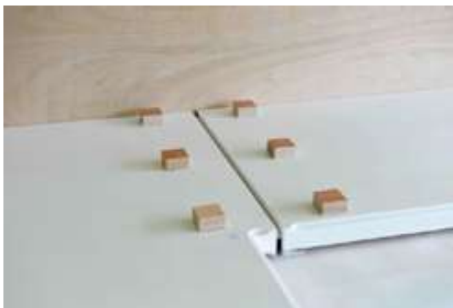
Cales en bois appliquées de part et d'autre du joint à l'aide d'une colle thermofusible.
